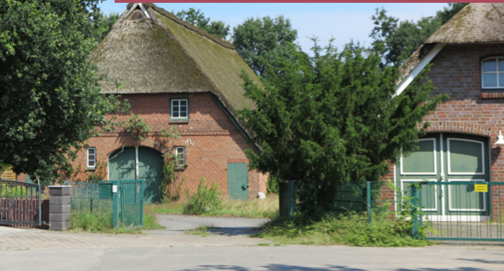
Alte Bauern-Häuser im Stadt-Teil
